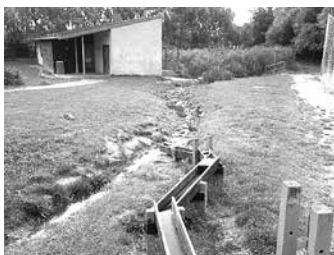
図7. ため池からの水路
