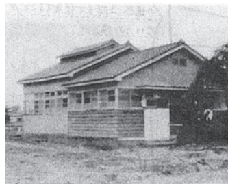
図8 職員共同浴場 注19 （年代不明・いわき市）
