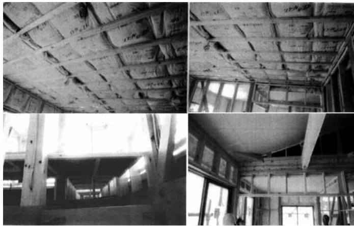
写真1 天井野縁の施工状況
