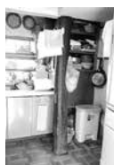
図13 カッテ北東に立つ独立柱 注24)
